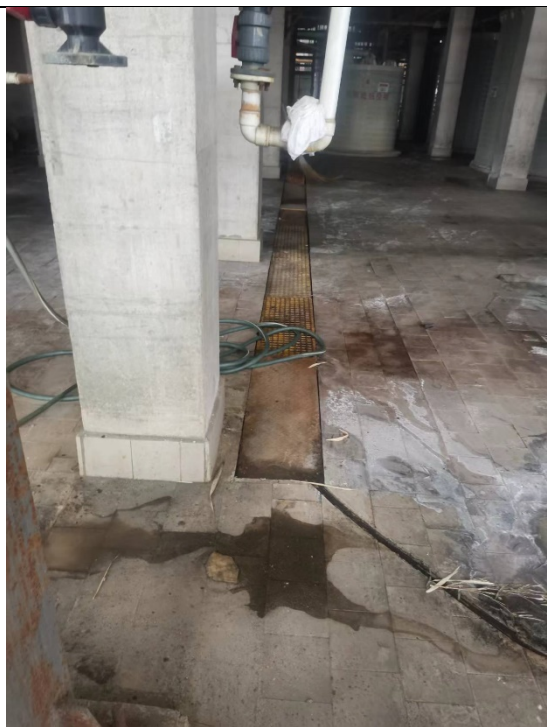
生产车间内导流槽
